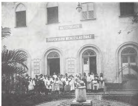
Pátio interno do Hospital Hahnemanniano, com vista para o Dispensário, no térreo, e para a Maternidade, no 1º andar. (acervo Souza Martins, IHB).
